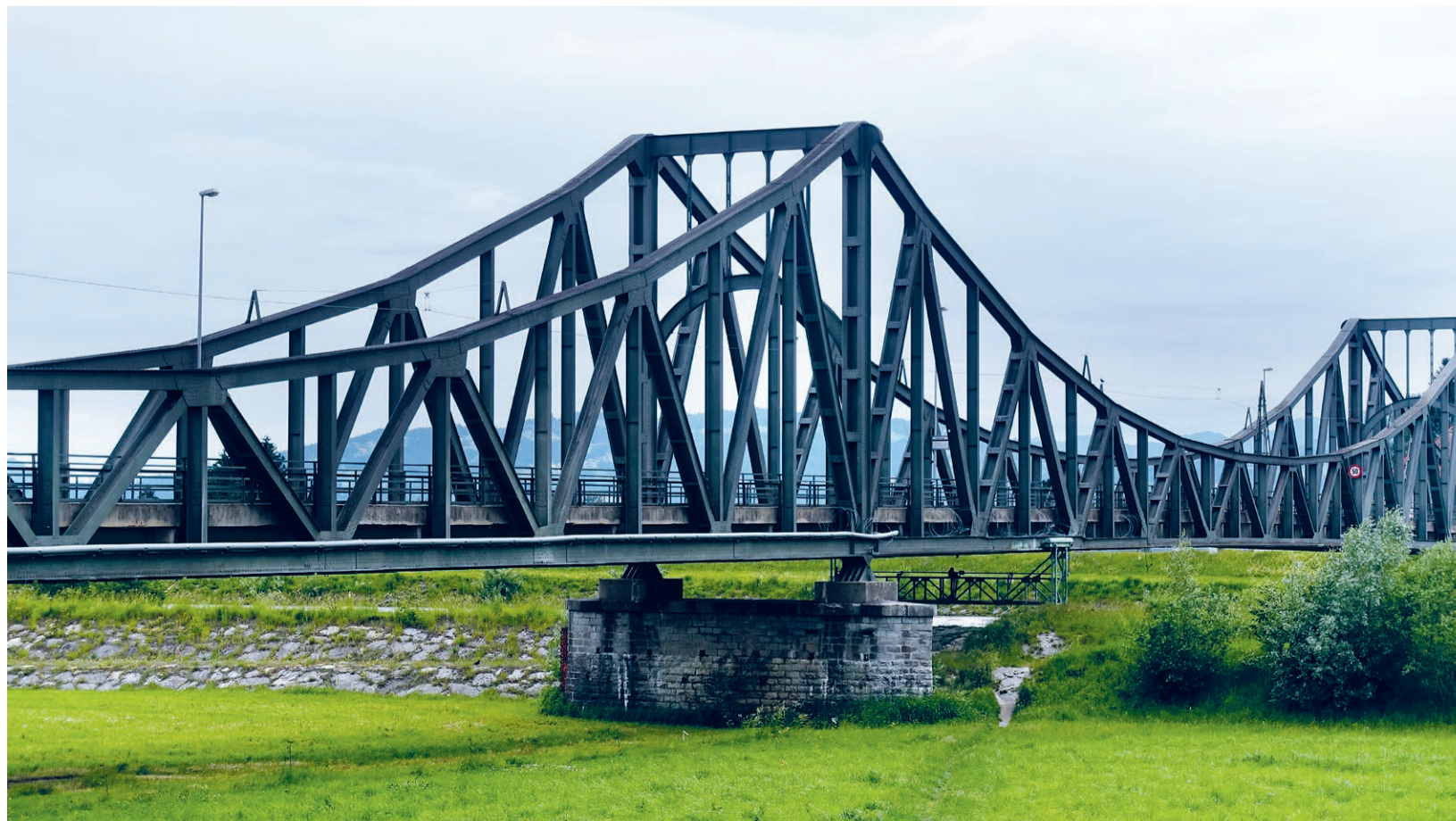
Die elegant geschwungene, zwischen 1911 und 1914 erstellte Wiesenrainbrücke imitiert mit ihrem Eisenfachwerk die Form einer Hängebrücke.
