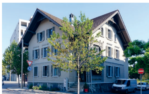
Das guterhaltene, wohlproportionierte Gebäude aus der Zeitepoche von 1870–1905 (Neugasse 1) ist durch Architekturelemente des Jugend- und Heimatstils geprägt.
