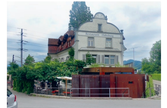
Die Hauptfassade des Restaurants wurde 1912 zur Brücke und damit auf die österreichische Kundschaft ausgerichtet. Darauf deutet auch der Name «Habsburg» hin.
