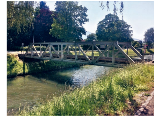
Funktionsfähig und in Betrieb: Die Viscose-Werkgeleisebrücke mit der Holzbalkeneinlage aus dem Jahr 1924.
