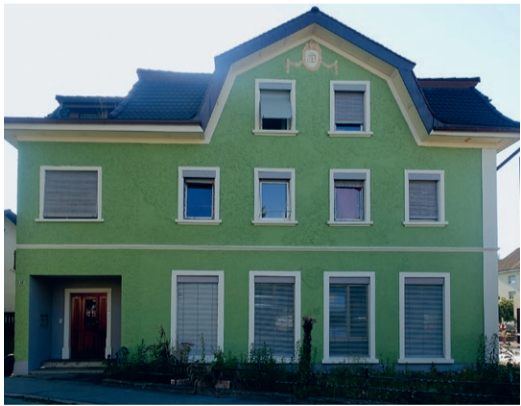
Die kleine Jugendstil-Stickereifabrik mit dem villenartigen Kopfbau an der Lindenstrasse 46 wurde 1912/1913 errichtet.
