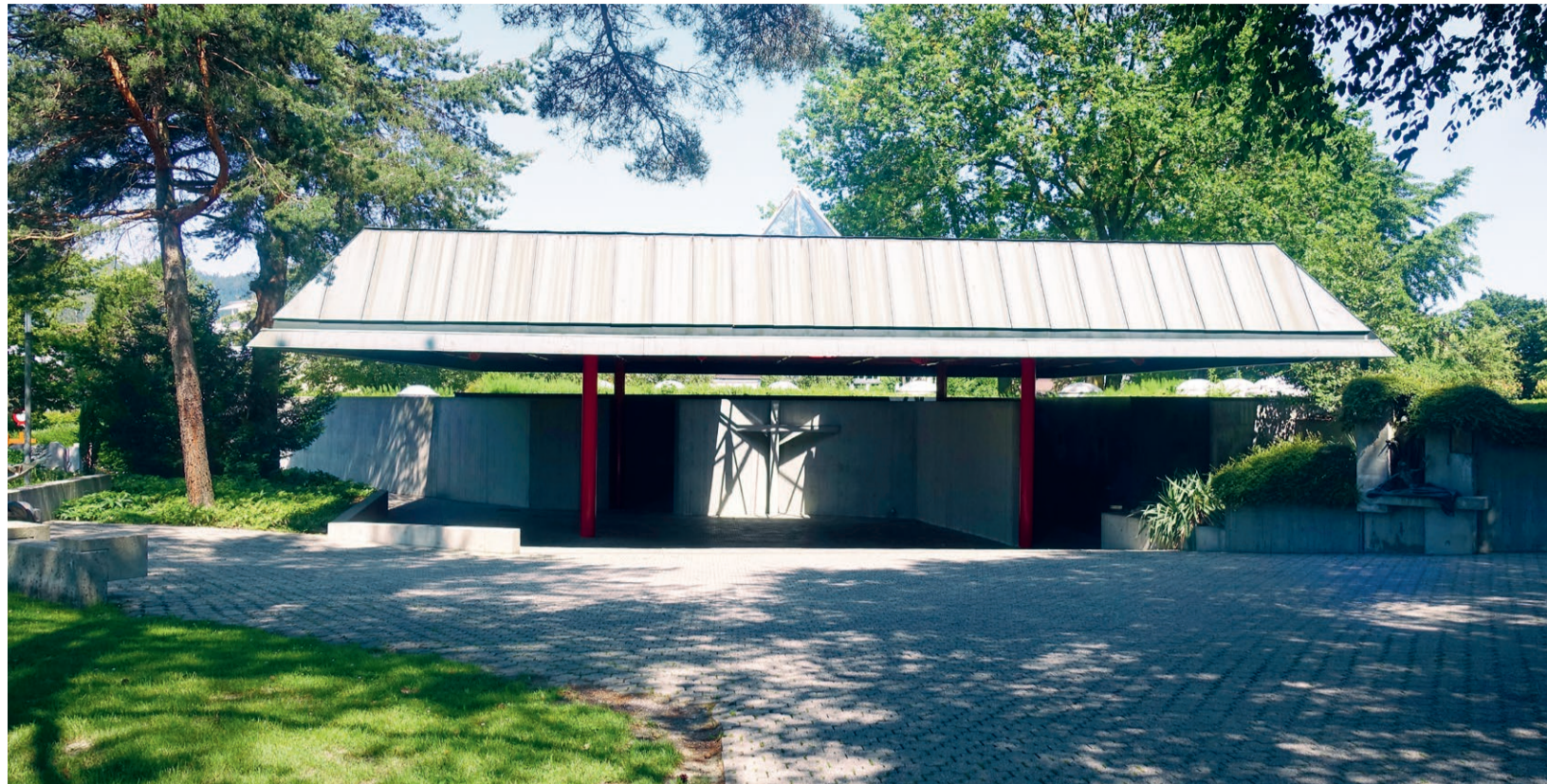
Die Abdankungshalle des bekannten Architekten Justus Dahinden bereichert die bemerkenswerte Friedhofsanlage.
