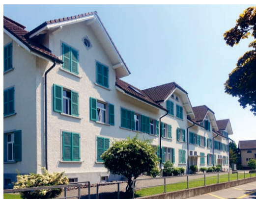
Die 1906 von Jacob Rohner an der Naglerstrasse 12 errichteten Stickerheime gelten als industriegeschichtlich wertvolle Objekte.
