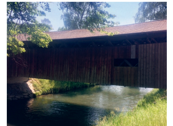
Die Nöllenbrücke ist eine der letzten gedeckten Holzbrücken im Rheintal.
